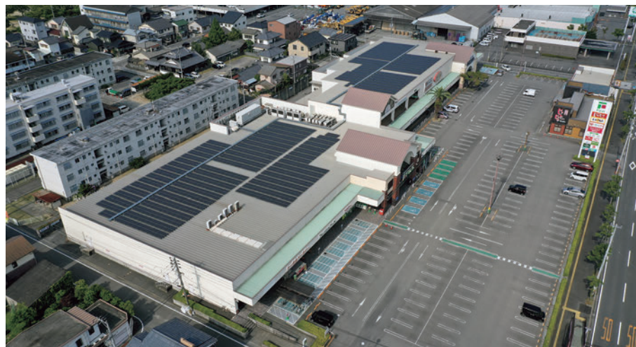
PPA 設置店舗
